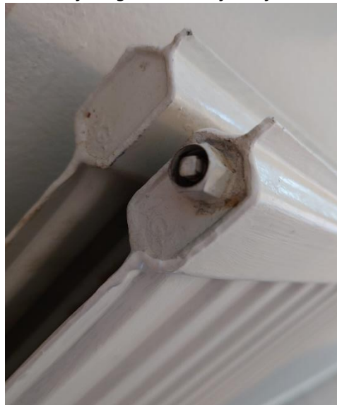
Avluftningsventil sett från sidan.
